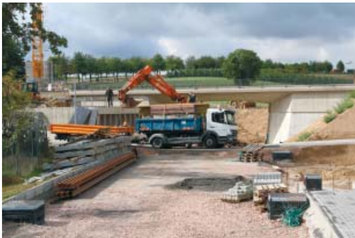
Ein größeres Kreuzungsbauwerk entsteht am Schnittpunkt mit der Bahnlinie Mainz - Alzey an der Station Mainz-Marienborn
