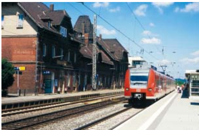
Im Bahnhof Eichenberg sollen die Bahnsteiganlagen modernisiert werden
