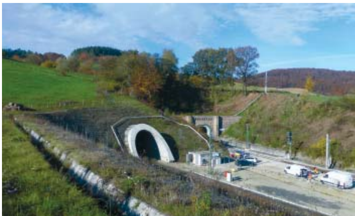
Südportal des neuen (links) und alten (rechts) Bebenrothtunnel Foto (Wikipedia): Trimberg
