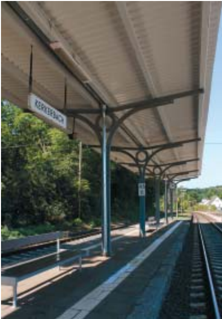
Die instandgesetzte Bahnsteigüberdachung im Bahnhof Kerkerbach Foto: H.-P. Günther
