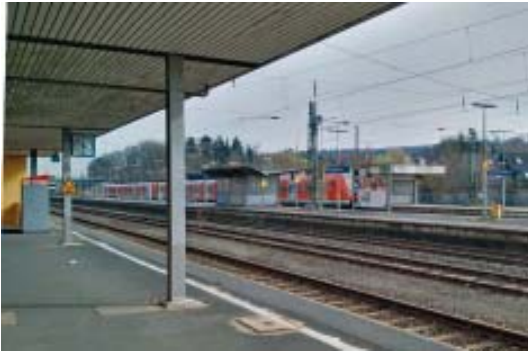
Die Bahnsteiganlagen in Niedernhausen sollen umfangreich modernisiert werden
