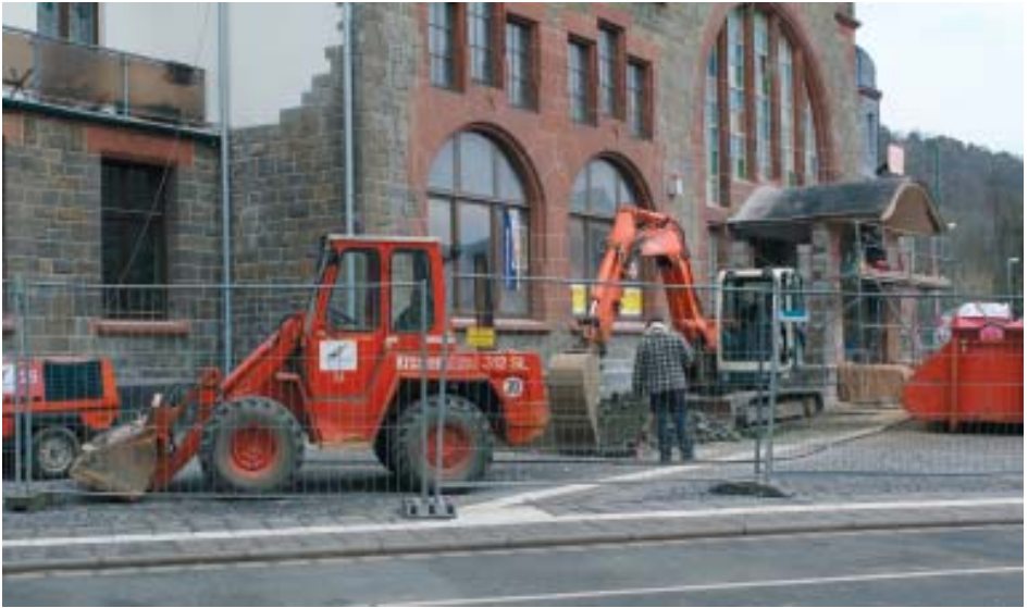
Momentan laufen Sanierungsarbeiten am Bahnhofsgebäude, welches der Stadt Herborn gehört. Die Bahnsteigunterführung erhält einen Durchstich nach Osten und am Gleis 1 wird ein Aufzug errichtet. Foto: Friedrich Lang
