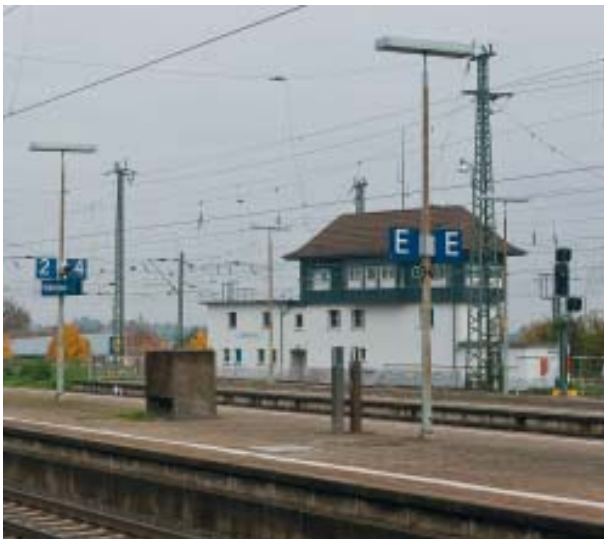
Früher hatte der Fahrdienstleiter vom Stellwerk aus einen guten Überblick über die Bahnsteige
