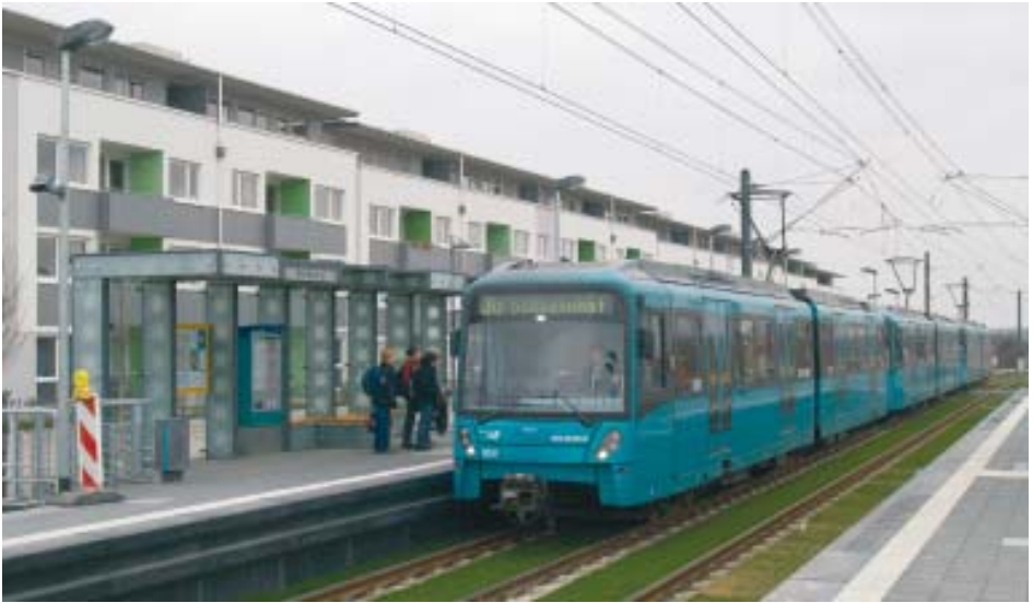
Bei der Riedberglinie U9 wurde der Lückenschluss zwischen zwei bestehenden Strecken bereits erfolgreich durchgeführt
