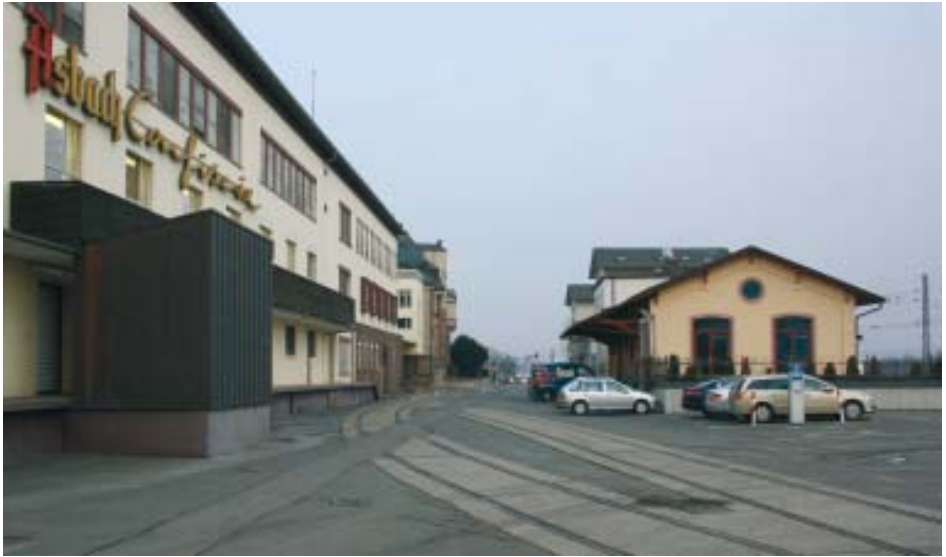
Für die Aufhebung des Bahnübergangs soll die B42 zwischen den jeweils unter Denkmalschutz stehenden Ensembles von Güterschuppen und Empfangsgebäude (rechts) und dem ehemaligen Betriebsgelände von Asbach durchgeführt werden. Foto: Hans-Peter Günther
