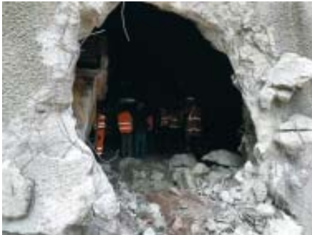
Nach dem Durchbruch werden jetzt mit der Verschalung der Tunnelinnenwand die Arbeiten fortgesetzt Foto: Kurhessenbahn
