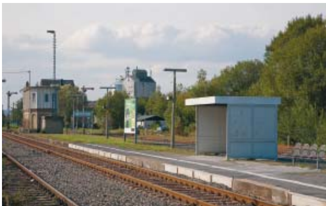
Der Bahnhof Hungen erhält neue Bahnsteiganlagen und eine verlängerte Bahnstufenunterführung mit zweitem Ausgang
