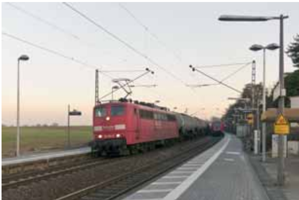
Neuer Bahnsteigbelag und Lampen, aber alte, niedrige Bahnsteigkante: Haltepunkt Ostheim bei Butzbach
