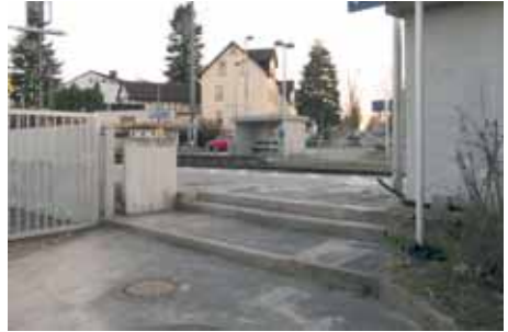
Der Bahnsteigzugang Richtung Gießen ist weiterhin nur über Stufen möglich
