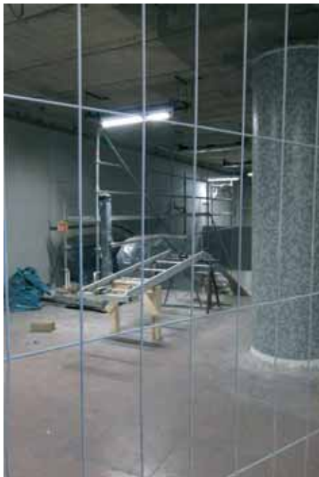
Bauarbeiten am S-Bahn-Haltepunkt Taunusanlage. Zur Zeit ist ein Abgang zur Gleisebene gesperrt Foto: Anke Cuntz
