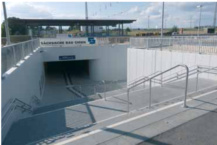
Eingang zur Unterf6hrung von der Stadtseite her. Von rechts f6hrt die Rampe zur Unterf6hrung hin
