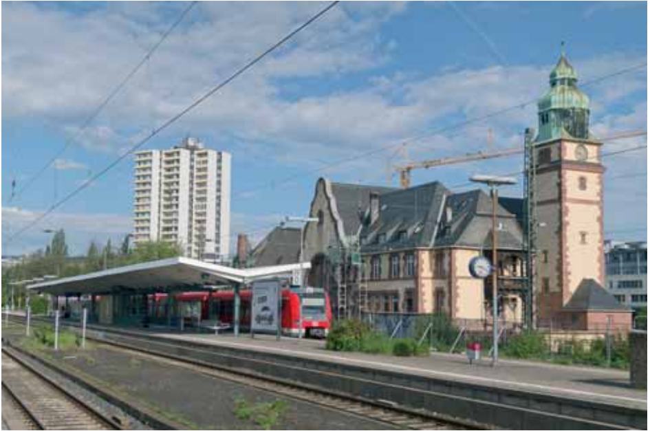
Der Bahnhof Bad Homburg soll Endpunkt der Stadtbahnlinie U2 werden. Neue Forderungen einer Landesbehörde nach alternativen Planungen verzögern das Vorhaben
