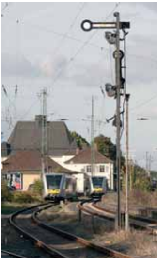
Die Bahnsteig- anlagen des Fried- berger Bahnhofs sollen auf Vordermann gebracht werden
