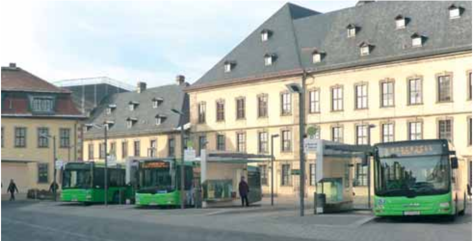
Der neue Zentrale Omnibusbahnhof (ZOB) in Fulda Foto: Michael Kolb
