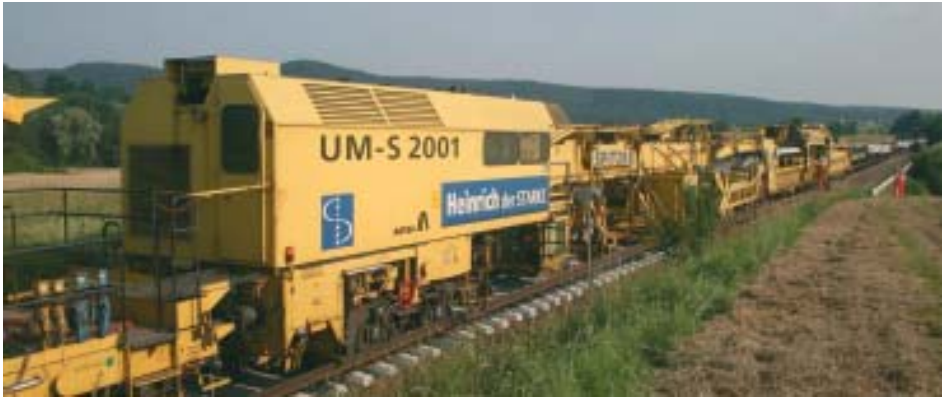
An der Strecke bei Ernsthäusen arbeitet sich am 9. Juli 2013 der Schnellumbauzug UM-S 2001 „Heinrich der Starke“ der Firma Spitzke talwärts und tauscht Schienen und Schwellen. Der vordere Zugteil mit den Schwellenwagen befährt noch das alte Gleis. Die Antriebseinheit am Zugende befährt schon die neuen Gleise. Foto: Jürgen Schmied
