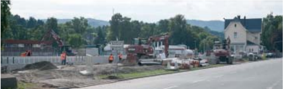
Bahnsteigneubau im Bahnhof Bad Laasphe
