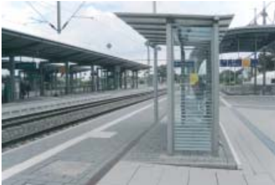
Am Hausbahnsteig gibt es nur wenige wettergeschützte Unterstellmöglichkeiten. Hinten rechts der überdachte Abgang zur Bahnunterführung 3 Fotos: Planungsbüro StadtLandBahn
