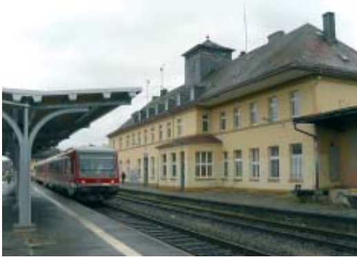
Der überdachte Bahnsteig in Frankenberg soll erhalten bleiben und wird renoviert
