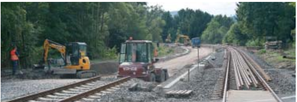
An der Westseite des Bahnhofs werden die Gleise komplett erneuert
