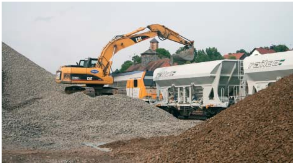
Solche Schotterberge erwarten den Bahnhof Frankenberg erneut beim Gleisumbau der Ebertalbahn. Wie bereits am 14. Juli 2013 bei Baumaßnahmen an der Burgwaldbahn, sollen die Arbeiten auch dieses Jahr von Frankenberg aus beginnen. Foto: Jürgen Schmied
