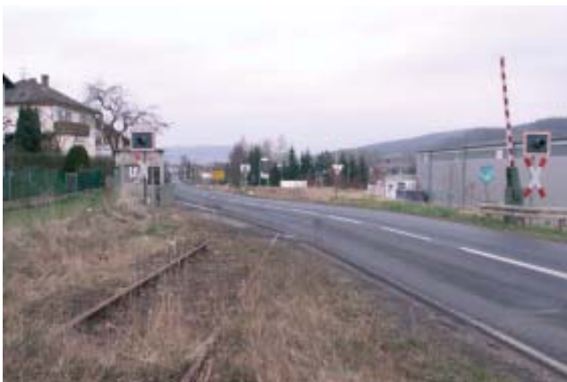
Zugeteerter Bahnübergang an der Sinntal-Kreuzbergbahn Jossa - Wildflecken
