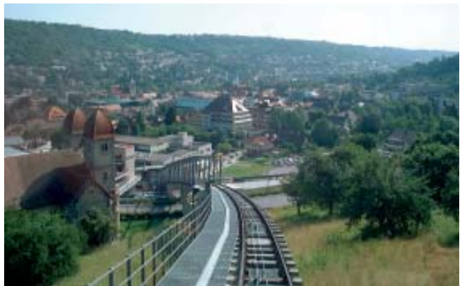
Künzelsau mit der Strecke der Standseilbahn Foto: Klaus Föhl (Wikipedia)
